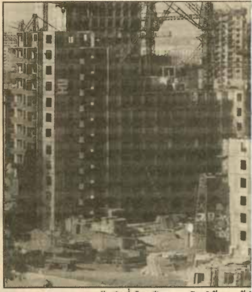
การสร้างตึกที่เมืองเปียงยาง โดยใช้ระบบน้ำ
