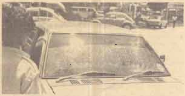
อากาศร้อน ความร้อนของอากาศในช่วงการสอบไล่ภาคฤดูร้อน/2525 ที่ผ่านมา ร้อนมากจนกระทั่ง กระชกหน้ารถยนต์ของอาจารย์ท่านหนึ่งที่จอดอยู่ข้างตึก NB 5 รั้วแตกไปหมด เหตุเกิดเมื่อตอนบ่าย วันอาทิตย์ที่ 22 พฤษภาคม 2526
