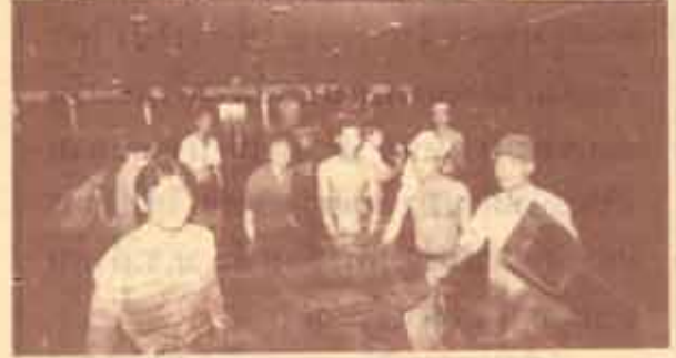
กู้เก้าอี้ เจ้าหน้าที่กองอาคารสถานที่ คือน้ำที่เก้าอี้เรียนจากอาคารเรียน NB ต่าง ๆ นำได้เรือไปไว้ที่อาคาร SAB
