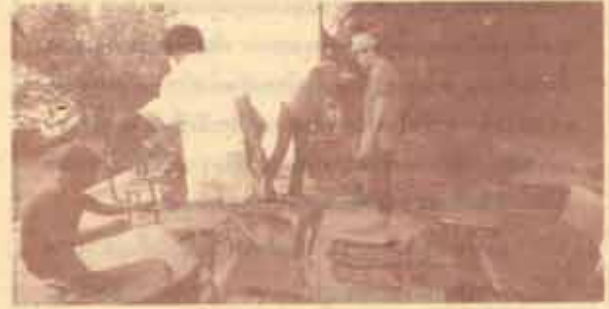
ซ่อมเก้าอี้ ตั้งแต่วันที่ 1 พฤศจิกายน 2526 เป็นต้นมา กองอาคารสถานที่ ระดมกำลังเจ้าหน้าที่ในการซ่อมแซมเก้าอี้เรียนที่ชำรุดจากน้ำท่วม ณ ชั้นล่าง อาคาร SAB เพื่อให้ทันการสอบ
