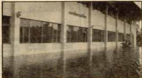
อาคารกิจกรรมนักศึกษาเทคโนฯที่ท่วมเหมือนกัน
