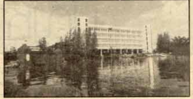
สภาพน้ำบริเวณลานพ่อบุญฯ ด้านอาคาร SAB
