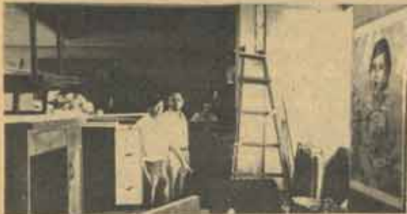
ปรับปรุงสถานที่ มหาวิทยาลัยกำลังปรับปรุงสถานที่ ณ สำนักงานอธิการบดี ชั้น 4 ซึ่งเป็นที่ทำงานของกองการเจ้าหน้าที่ และกองกลาง เพื่อขยายให้กว้างขวางยิ่งขึ้น
