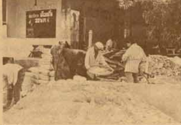
ศูนย์คอมพิวเตอร์ คณะเศรษฐศาสตร์ กำลังก่อสร้างสถานที่ทำการของคณะเพิ่มเติม เพื่อเป็นที่ทำการของศูนย์วิจัย และศูนย์คอมพิวเตอร์ที่จะรองรับการเปิดสอนระดับปริญญาโทในอนาคต
